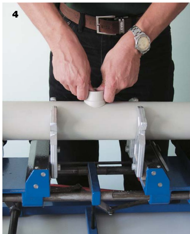
4 Nahřáté sedlo nasuneme do nahřátého otvoru a fixujeme cca 16 s. Po uplynutí jedné hodiny lze napustit vodou a namáhat tlakem.
