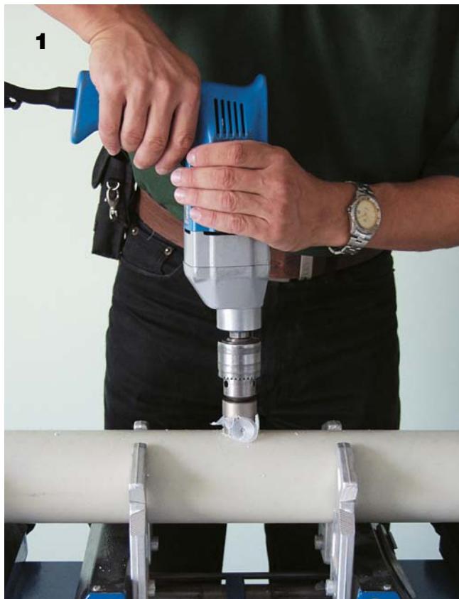
1 Speciálním vrtákem vyvrtáme otvor pro potrubí.
